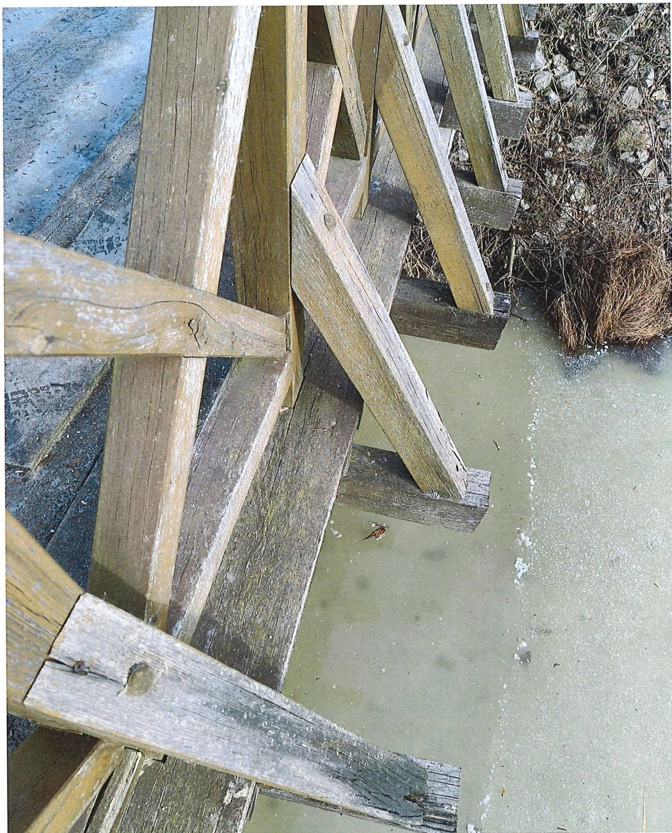
Widok zdegradowanego biologicznie zastrzału balustrady.
