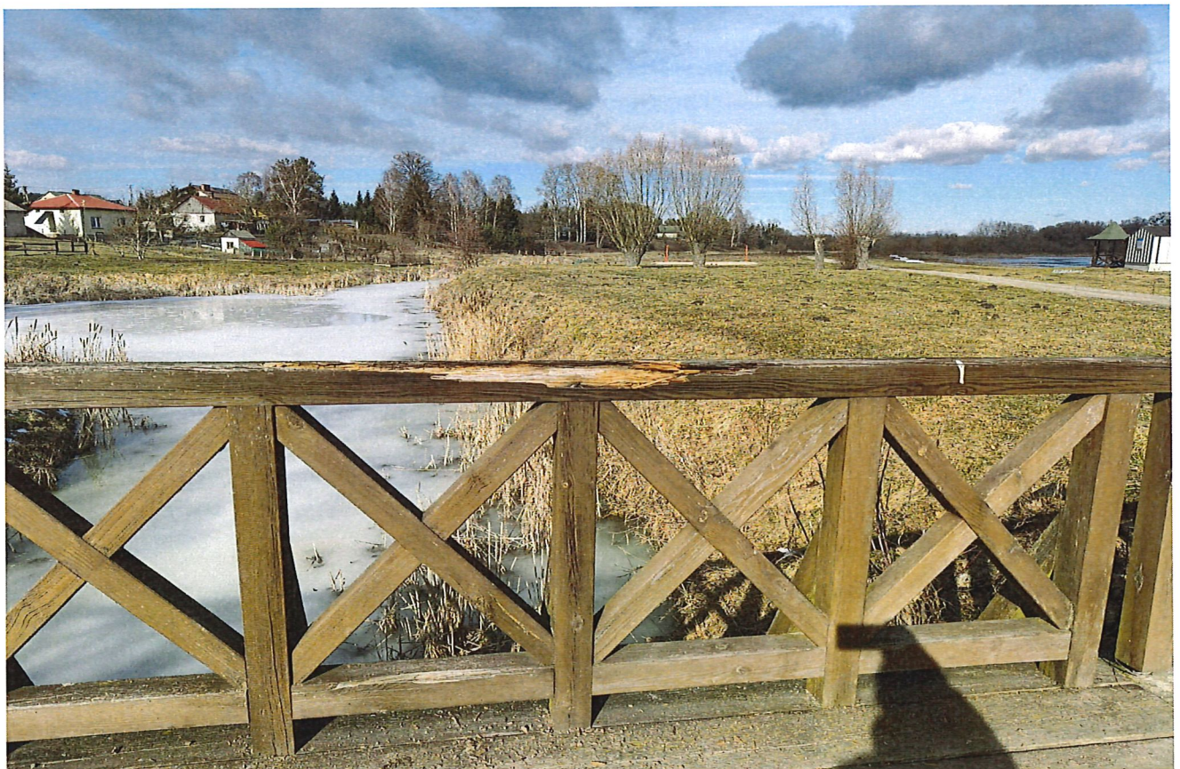
Widok zniszczonej poręczy balustrady od strony północnej.
