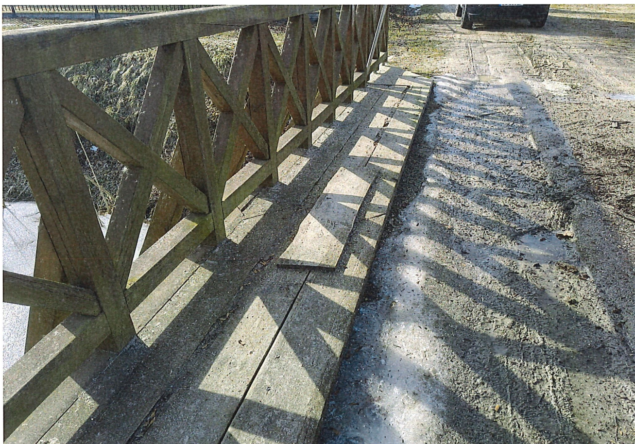
Widok zniszczonej nawierzchni chodnika strona prawa – naprawianej doraźnie. Widoczne ubytki w dylinie górnej.
